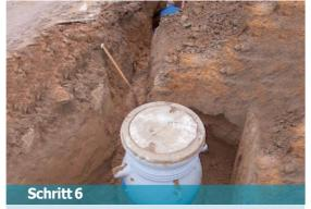
Ausheben der Kanäle für die Leitungen vom Haus zum Compit und vom Compit zur Druckentwässerung.
