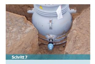
Aufschrauben des Compit-seitigen Anschlussesfürdie Druckleitung.
