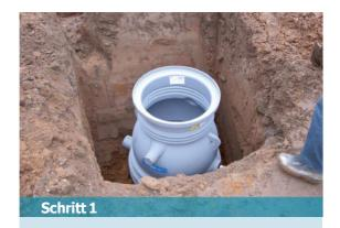
An geeigneter Stelle zwischen Hausabwasserleitung und dem kommunalen Anschluss an die Druckentwässerung eine mindestens 2 x 3 Meter tiefe Grube ausheben.
