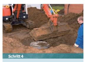
Die Grube bis über den Standfuß mit rolligem Boden auffüllen und die waagerechte Ausrichtung mit Wasserwaage kontrollieren.
