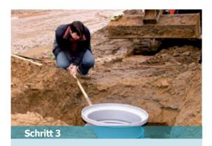
Den Compit entsprechend der Anschlüsse drehen und mit einer Wasserwaage ausrichten. Dies kann per Hand erfolgen.
